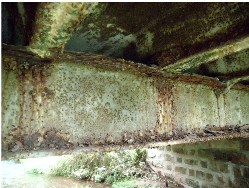
Foto č.13 - Pohled na zrezavělé pásnice hlavních ocelových nosníků.
