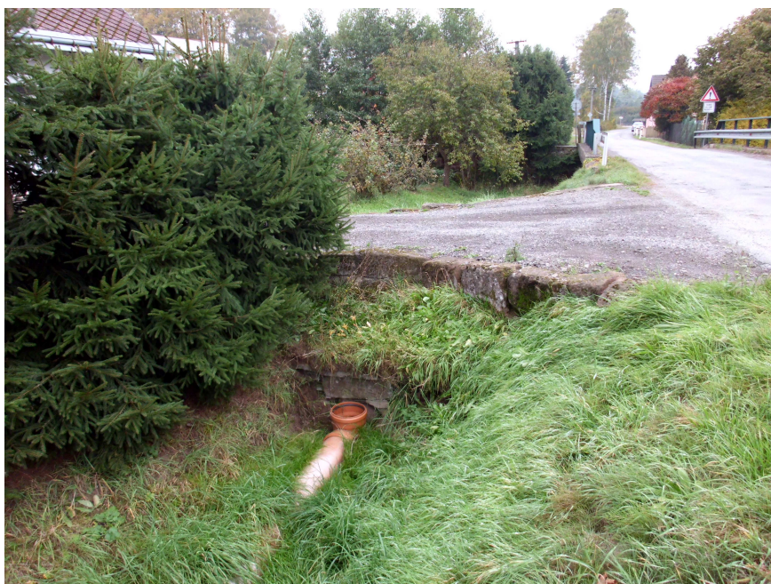
Foto č.18 - Pohled na propustek pod sjezdem situovaným za mostem po pravé straně. V propustku je umístěna splašková kanalizace.
