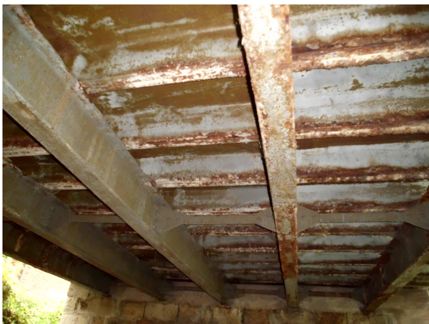
Foto č.12 - Pohled na nosnou konstrukci mostu ev.č. 29932-2 z ocel. nosníků I, příčníků a Larsen.
