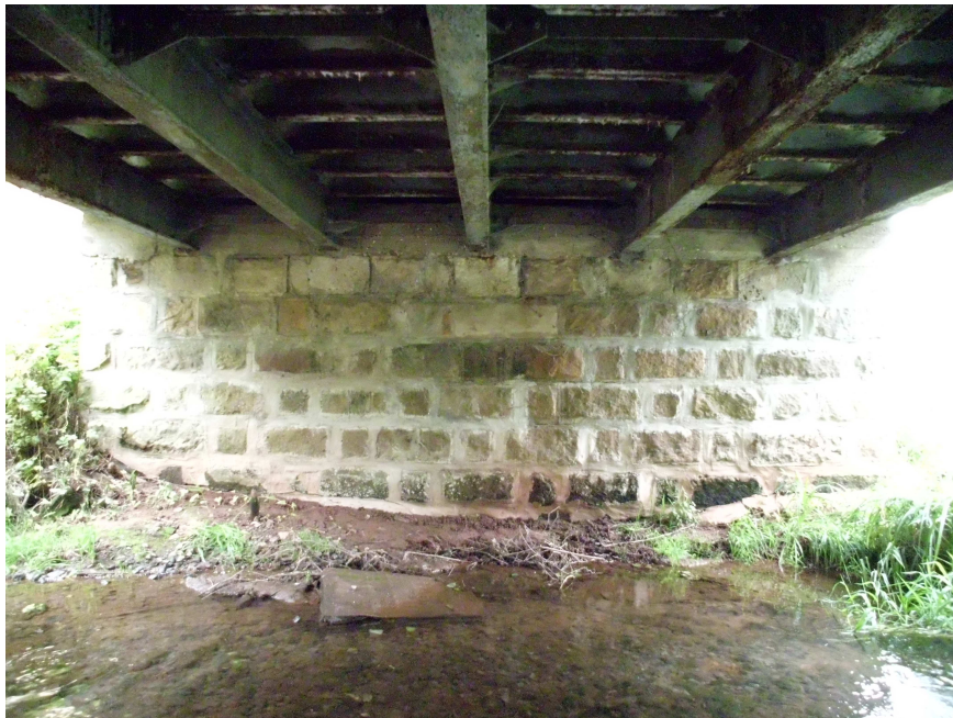
Foto č.11 - Pohled na opěru 02 mostu ev.č. 29932-2 z pískovcového zdiva.
