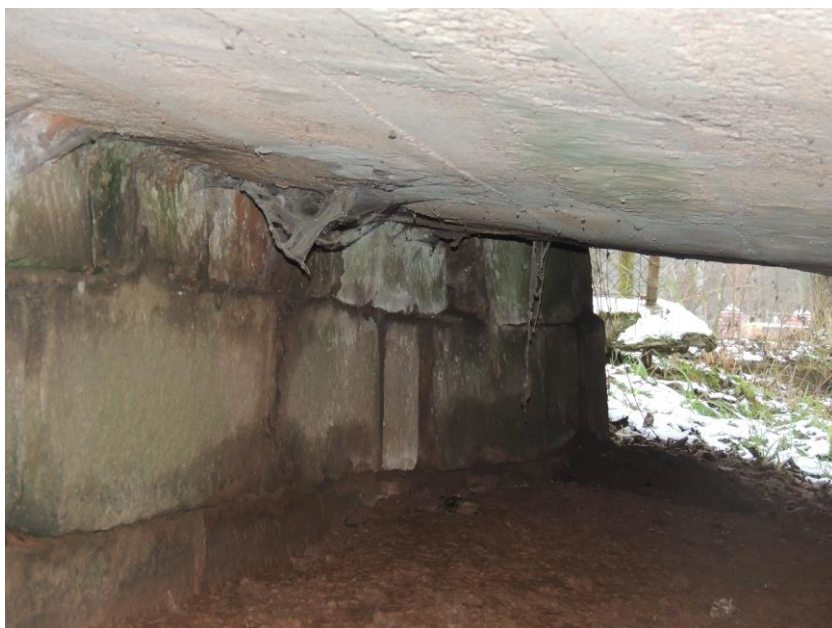
Detail části pravé opěry s kameny uvolněnými z původní pozice
