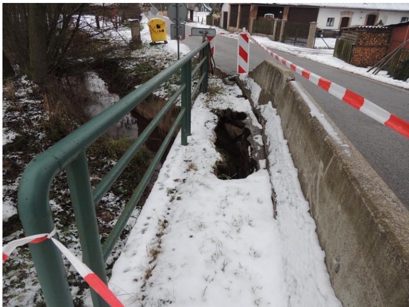
Propad vozovky v místě rozšíření původní nosné konstrukce mostu
