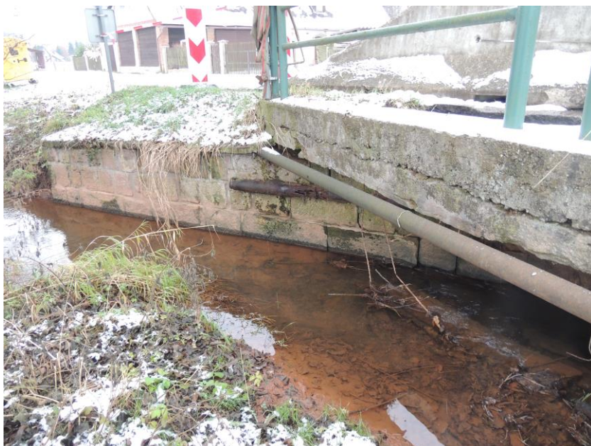
Detail části levé opěry s kameny uvolněnými z původní pozice
