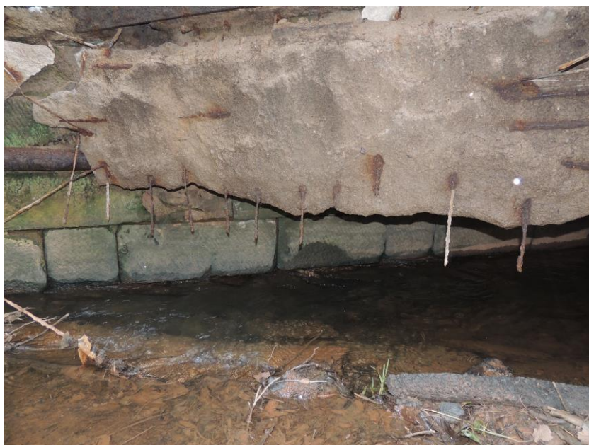
Detail visící části rozšíření původní nosné konstrukce mostu v místě propadu vozovky
