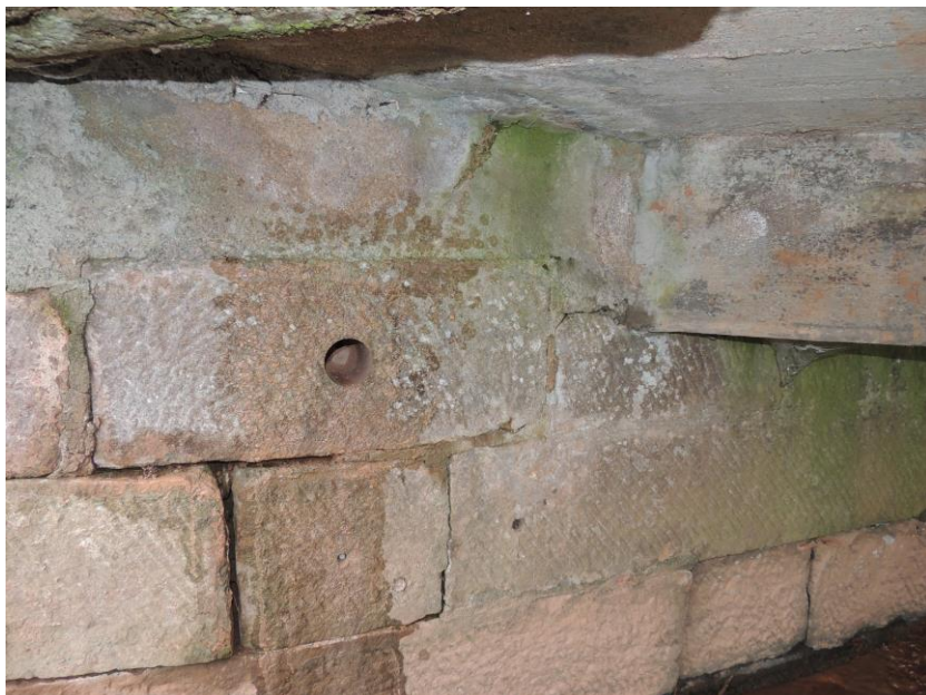
Místo odběru zkušebního vzorku pro stanovení pevnosti kamene opěry
