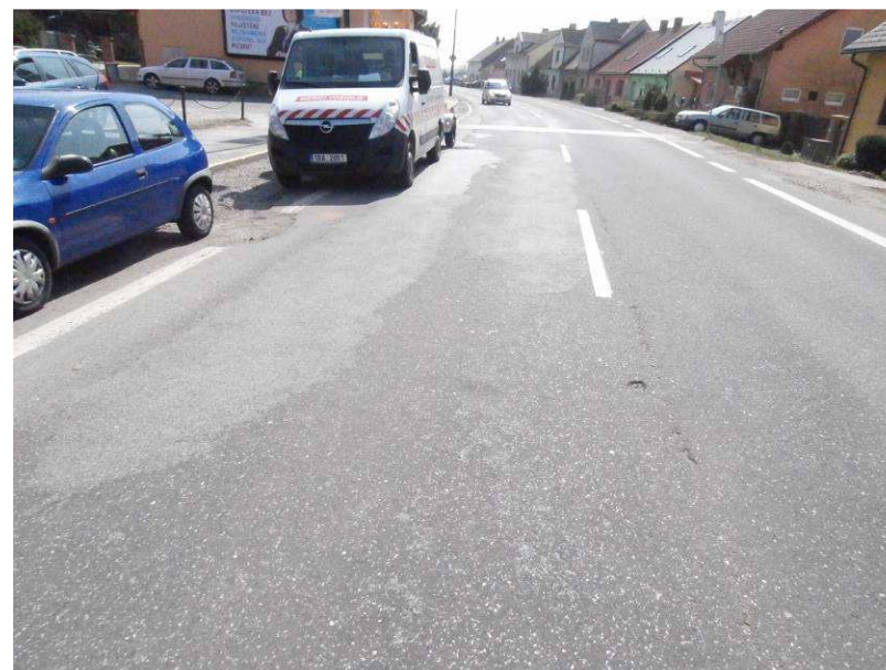
Výtluk, podélná trhлина, vysprávky
