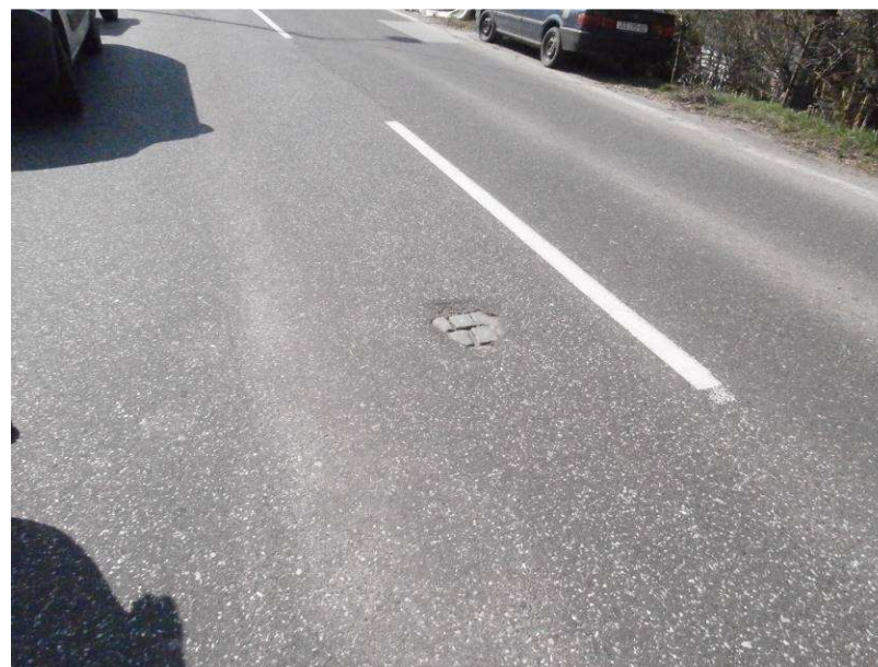
Výtluk (viditelná podkladní vrstva z dlažebních kostek)
