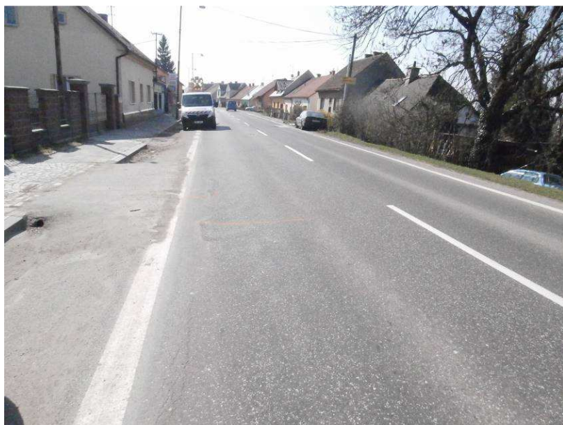
Vyjeté koleje, ztráta makrotextury
