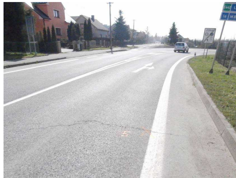
Příčná trhlina
