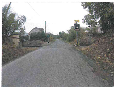
Hlubková koroze, mozaikové trhliny, vysprávk
