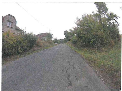
Ztráta mikrotextury, mozaikové trhliny, vysprávk
