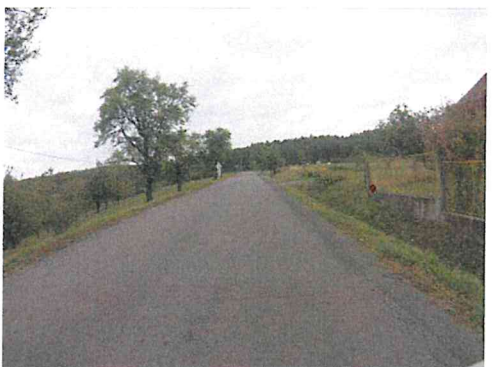
Ztráta makrotextury, mozaikové trhliny
