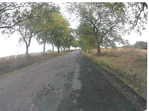
Ztráta mikrotextury, mozaikové trhliny, vysprávky
