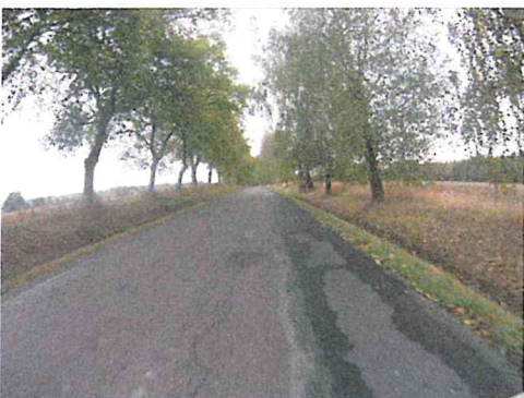
Ztráta mikrotextury, mozaikové trhliny, vysprávky
