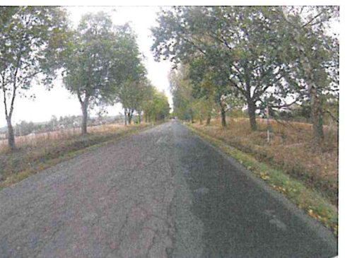
Ztráta mikrotextury, mozaikové trhliny, vysprávky
