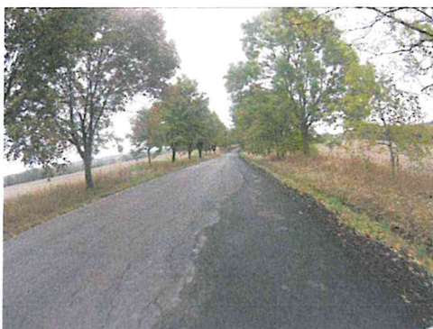
Ztráta mikrotextury, mozaikové trhliny, vysprávky
