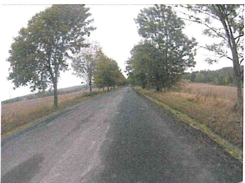
Ztráta mikrotextury, mozaikové trhliny, vysprávky
