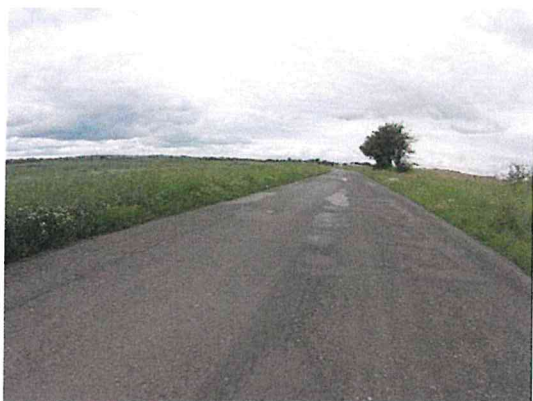
Vysprávkky, mozaikové trhliny, ztráta asfaltového tmele
