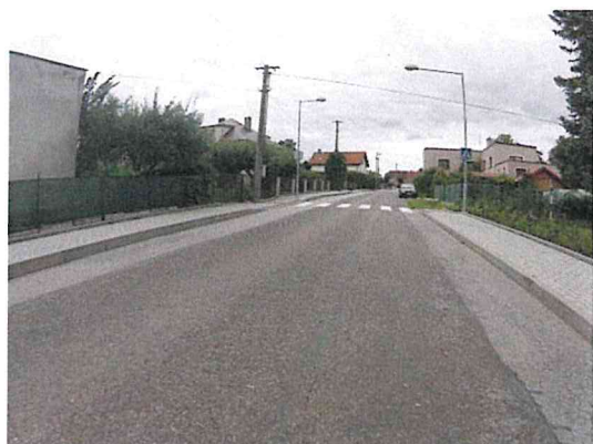
Vysprávký, ztráta makrotextury, mozaikové trhliny
