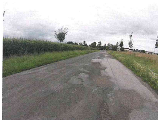
Vysprávký, hloubková koroze, mozaikové trhliny
