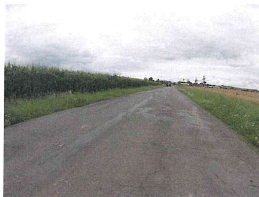
Vysprávký, ztráta asfaltového tmele, mozaikové trhliny
