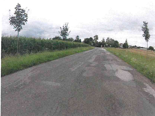
Vysprávky, hloubková koroze, mozaikové trhliny
