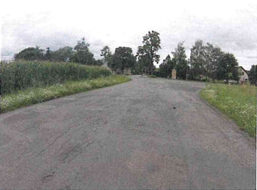
Mozaikové trhliny, výtlučky, ztráta asfaltového tmele
