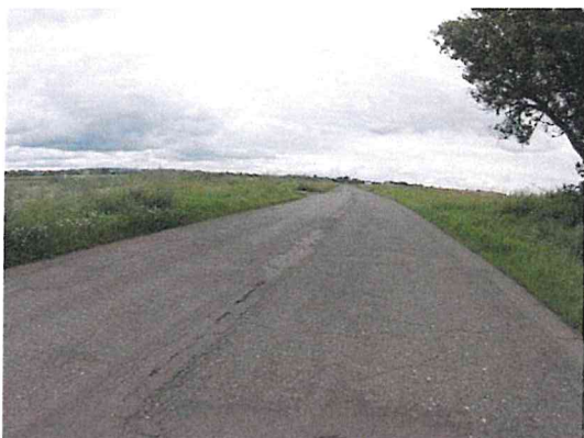
Vysprávkky, ztráta asfaltového tmele, mozaikové trhliny
