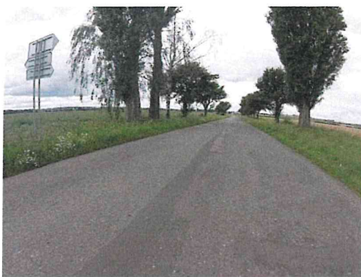
Vysprávký, mozaikové trhliny, ztráta makrotextury
