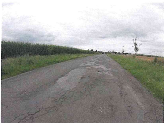
Vysprávký, mozaikové trhliny, hloubková koroze
