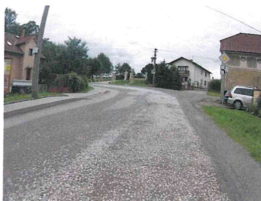
Vysprávký, ztráta asfaltového tmele, mozaikové trhliny
