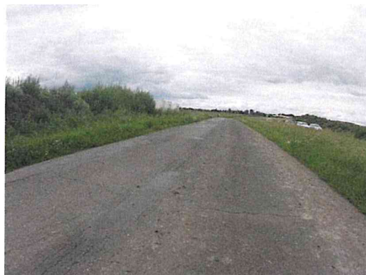
Vysprávkky, mozaikové trhliny, příčná trhlina
