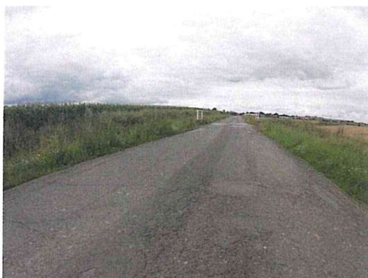
Vysprávký, mozaikové trhliny, hloubková koroze
