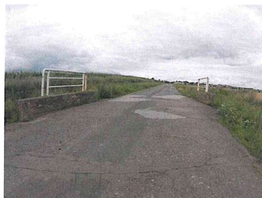
Vysprávký, ztráta asfaltového tmele, mozaikové trhliny
