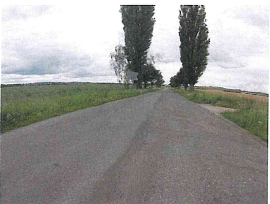
Vysprávký, ztráta makrotextury, mozaikové trhliny
