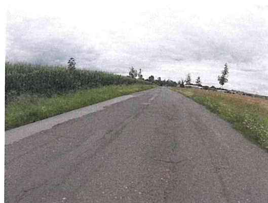
Vysprávký, ztráta asfaltového tmele
