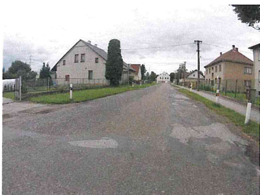
Vysprávký, ztráta makrotextury, mozaikové trhliny
