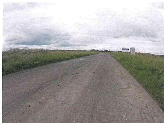
Vysprávkky, ztráta asfaltového tmele, mozaikové trhliny
