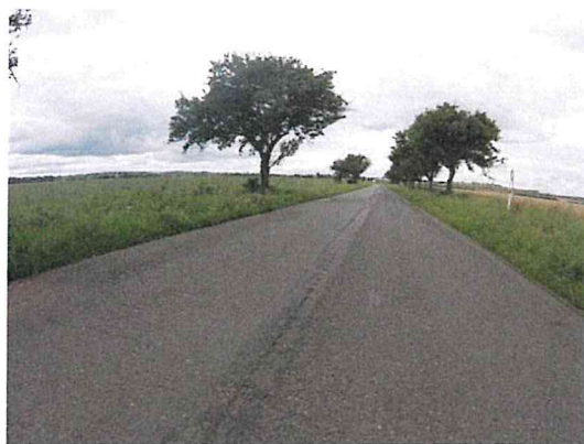
Vysprávký, trhлина široká podélná, mozaikové trhliny
