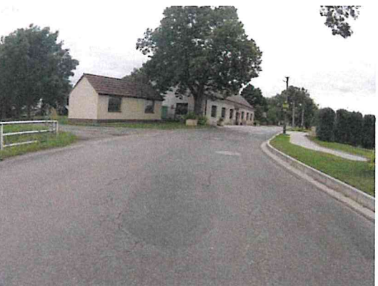
Vysprávky, ztráta makrotextury, mozaikové trhliny
