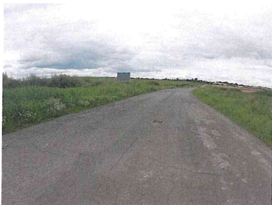
Mozaikové trhliny, výtluky, ztráta asfaltového tmele
