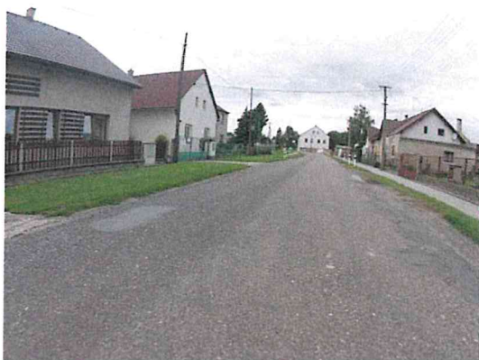
Vysprávký, ztráta asfalt. tmele, olam. okrajů vozovky
