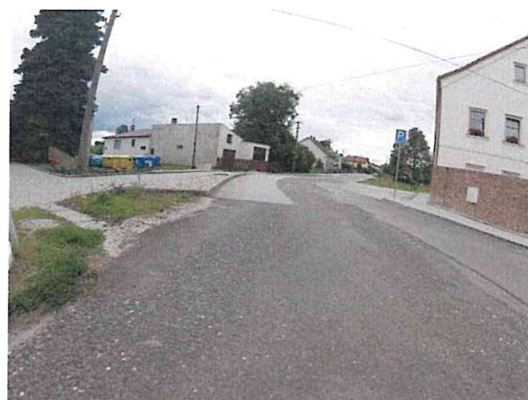
Vysprávký, ztráta asfaltového tmele
