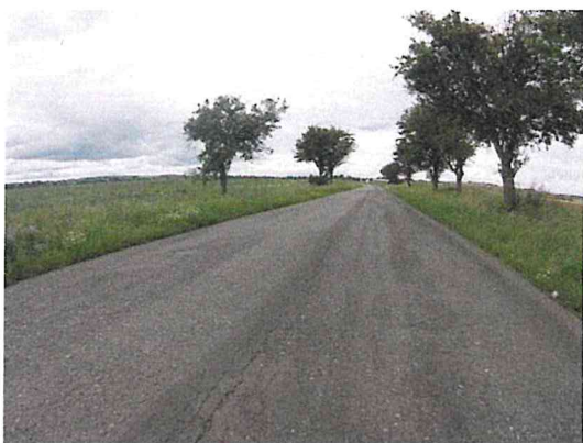
Mozaikové trhliny, ztráta makrotextury
