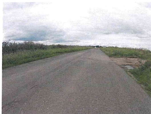
Vysprávkky, ztráta asfaltového tmele, mozaikové trhliny
