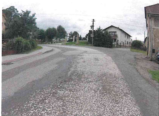
Vysprávký, ztráta asfaltového tmele
