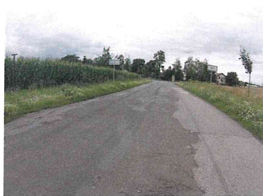
Vysprávky, hloubková koroze, mozaikové trhliny
