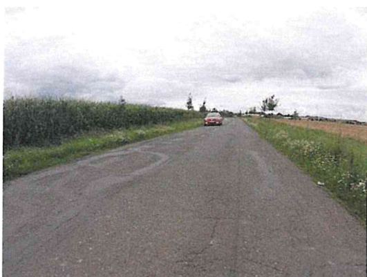
Mozaikové trhliny, hloubková koroze
