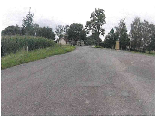
Vysprávky, hloubková koroze, mozaikové trhliny
