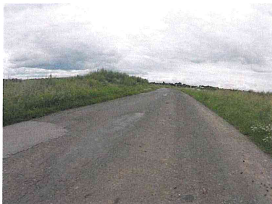
Vysprávkky, mozaikové trhliny, ztráta asfaltového tmele
