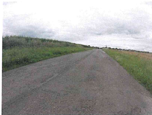
Vysprávký, hloubková koroze, mozaikové trhliny
