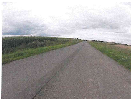
Vysprávka, podélná trhлина, ztráta asfaltového tmele
