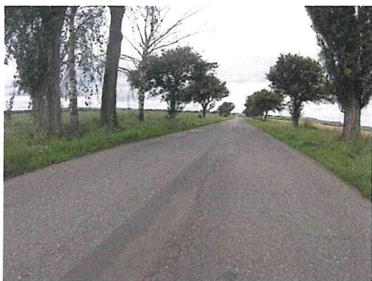
Vysprávký, mozaikové trhliny, ztráta asfaltového tmele
