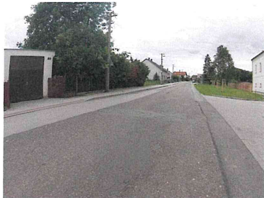
Vysprávký, ztráta asfaltového tmele, mozaikové trhliny
