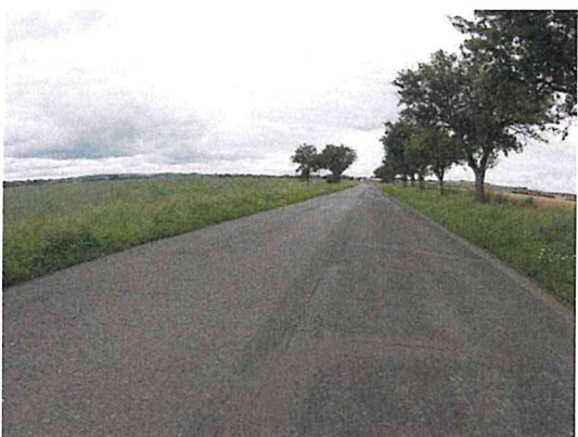
Vysprávký, podélná trhлина, příčná trhлина
