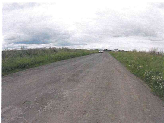
Vysprávkky, ztráta asfaltového tmele, mozaikové trhliny
