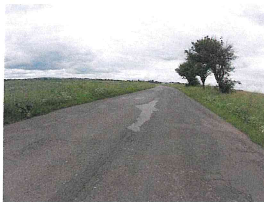
Vysprávkky, mozaikové trhliny, ztráta asfaltového tmele
