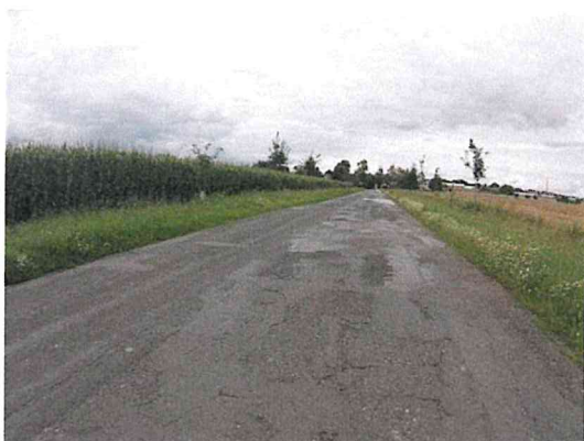
Vysprávký, mozaikové trhliny, hloubková koroze
