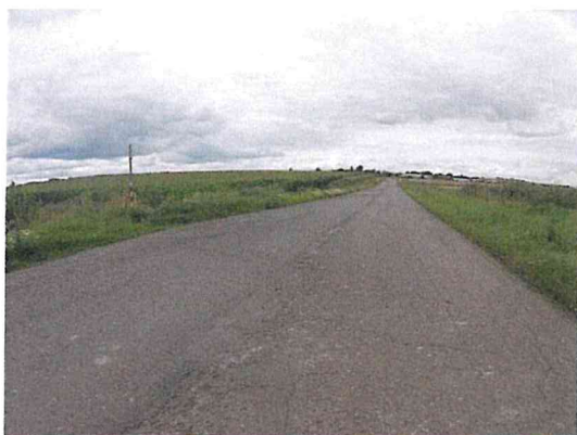
Mozaikové trhliny, ztráta asfaltového tmele
