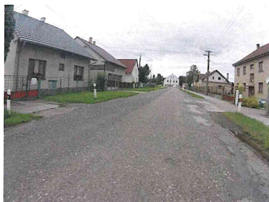
Vysprávký, ztráta makrotextury, mozaikové trhliny
