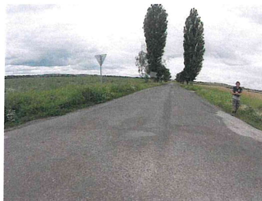
Vysprávký, ztráta asfaltového tmele
