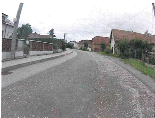
Vysprávký, ztráta asfaltového tmele
