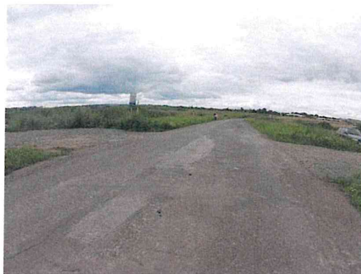
Vysprávký, ztráta asfaltového tmele, mozaikové trhliny
