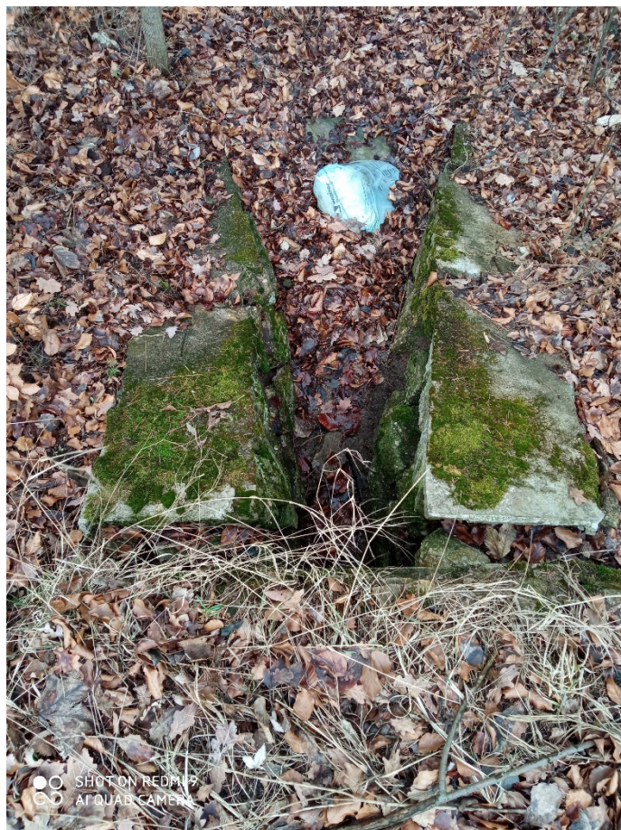
Příčný propustek v km 0,693 bude pročištěn. Čela propustku budou provedna nová, šikmá z lomového kamene.
