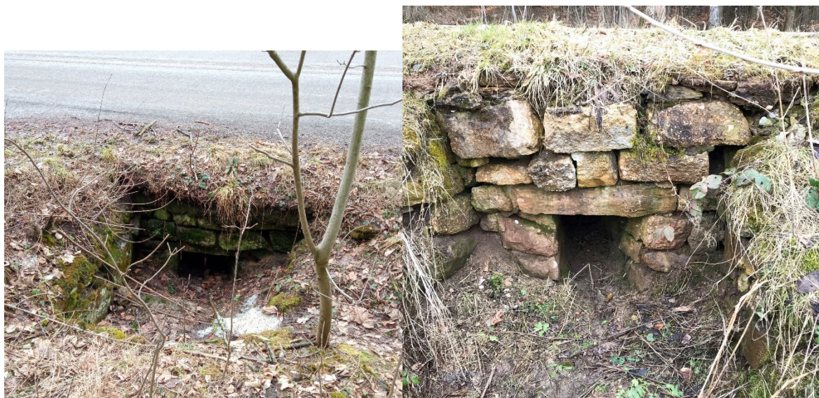
Příčný propustek v km 0,549 bude pročištěn. Čela propustku budou provedna nová, šikmá z lomového kamene.
