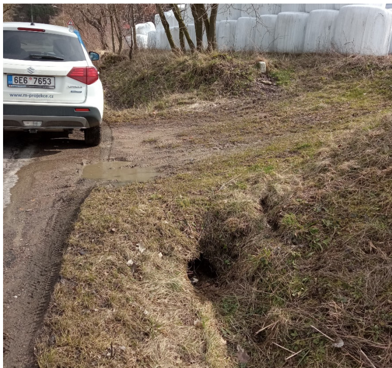
Stávající podélný propustek v km 0,100 bude vyměněn.
