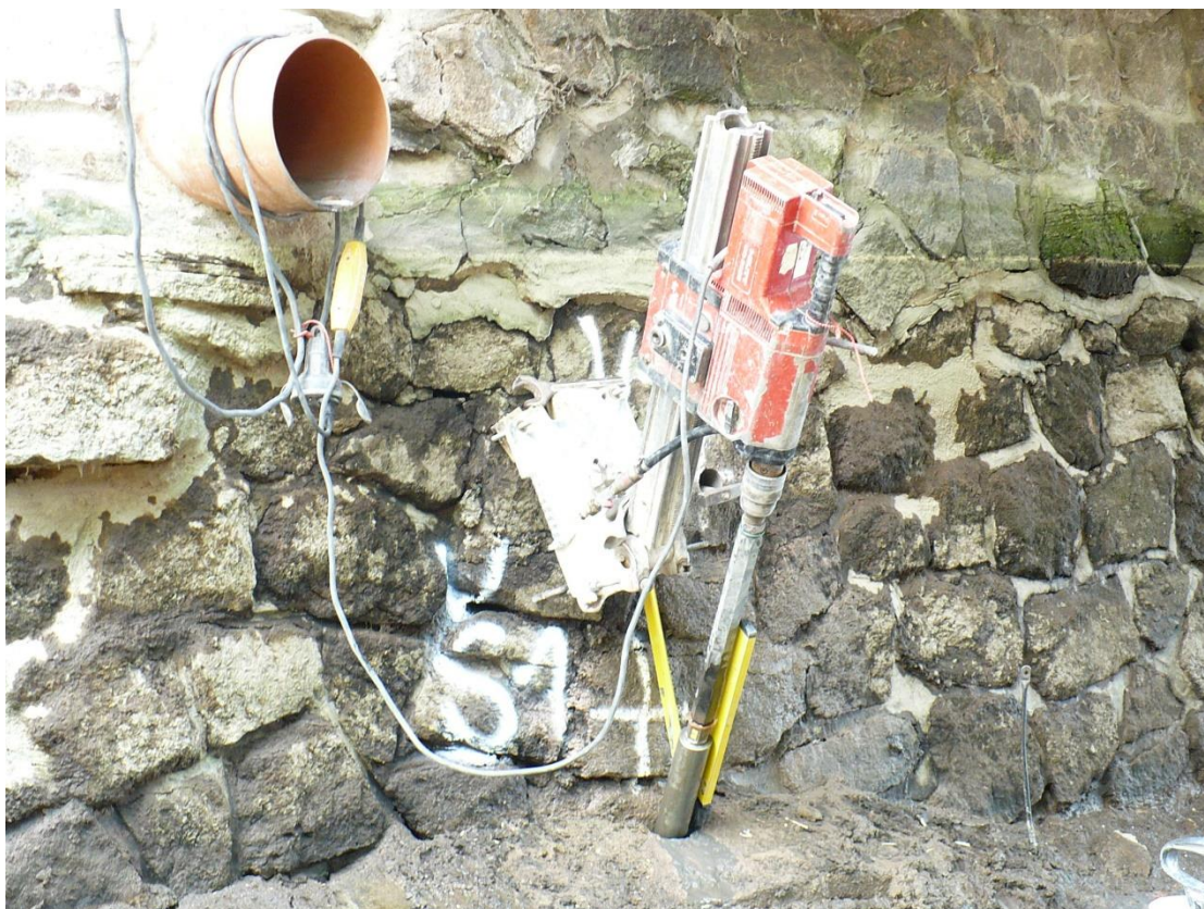
Foto 17: šikmý vrt Š-2 Detailní pohled na místo vývrtu
