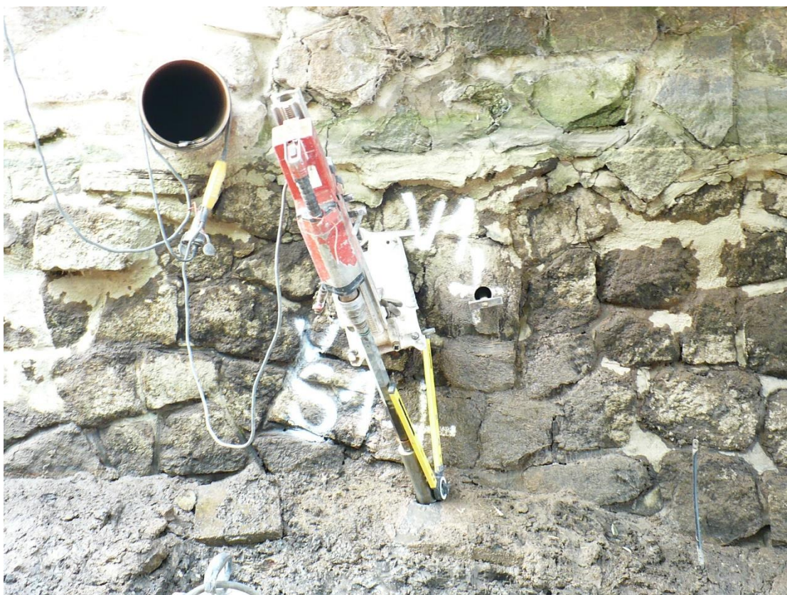
Foto 16: šikmý vrt Š-2 Detailní pohled na místo vývrtu
