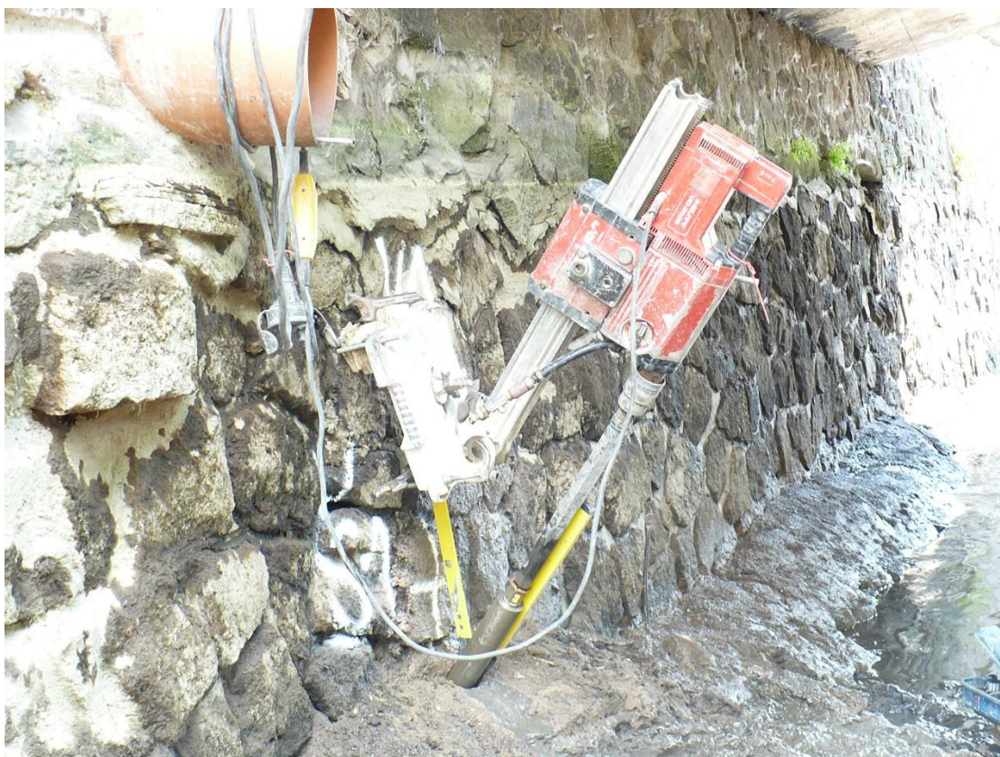
Foto 18: šikmý vrt Š-2 Detailní pohled na místo vývrtu
