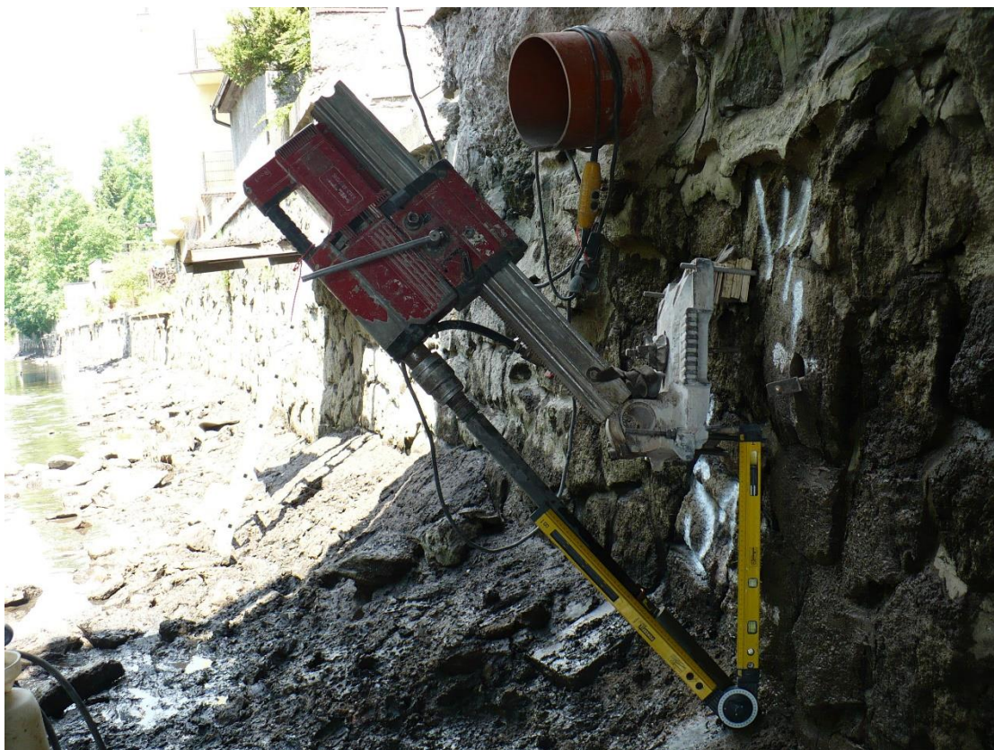
Foto 15: šikmý vrt Š-2 Detailní pohled na místo vývrtu
