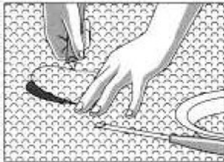
Podél vnitřní strany vpusti je vyříznut otvor do krytiny a horkým vzduchem vytvarován dovnitř vpusti
