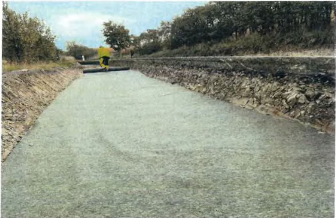
Pokládka netkané geotextilie 500g/m 2 na úroveň parapláně
