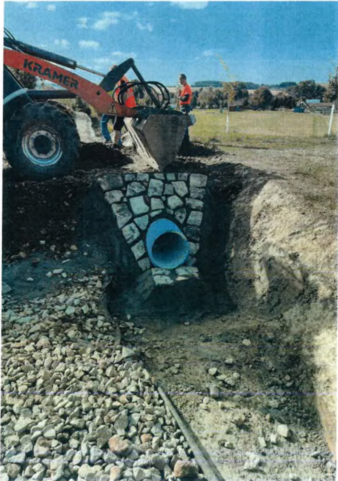
Podélný propustek DN 400 včetně šikmých čel
