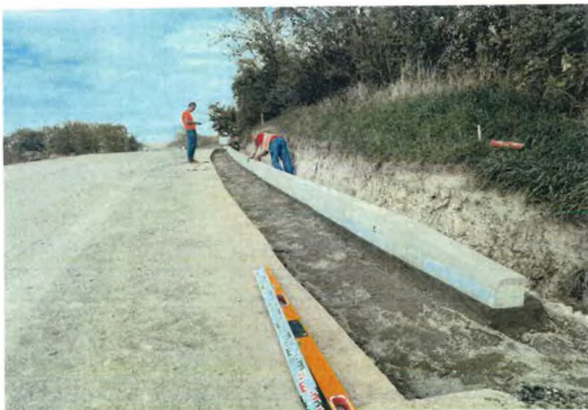
Pokládka silničních obrub do bet. lože v délce 50m
