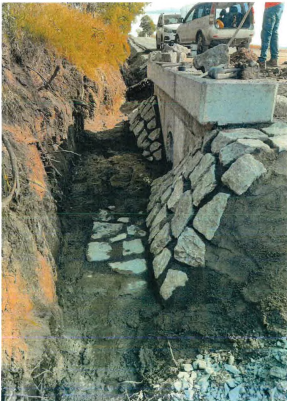
Odláždění propustku DN 500 v km 5,436
