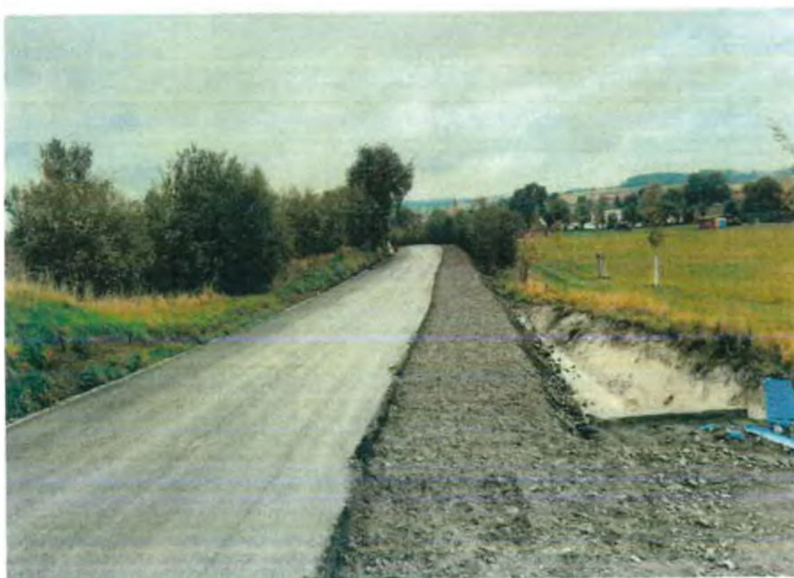
Zhotovení I. konstrukční vrstvy ze ŠD tl. 150 mm
