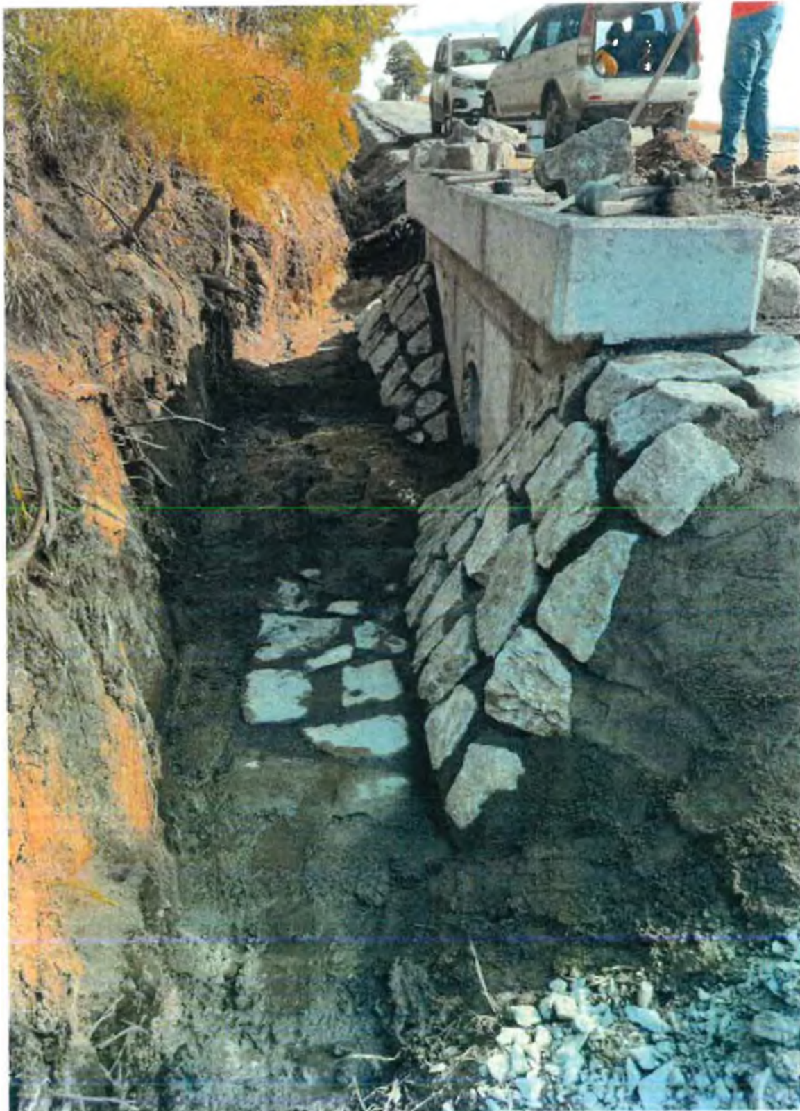
Odláždění propustku DN 500 v km 5,436
