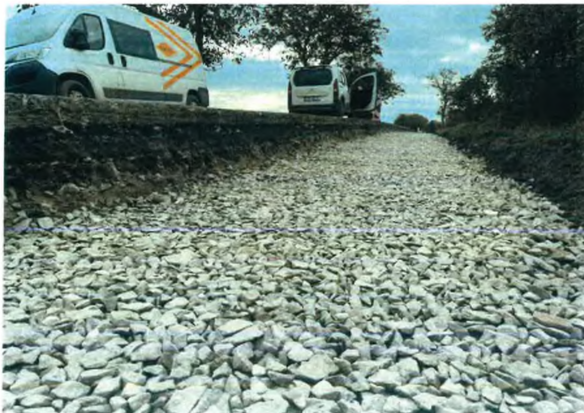
Vrstva pro ŠCM z kamene 32/63 tl. 150 mm
