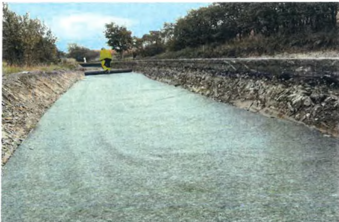
Pokládka netkané geotextilie 500g/m2 na úroveň parapláně
