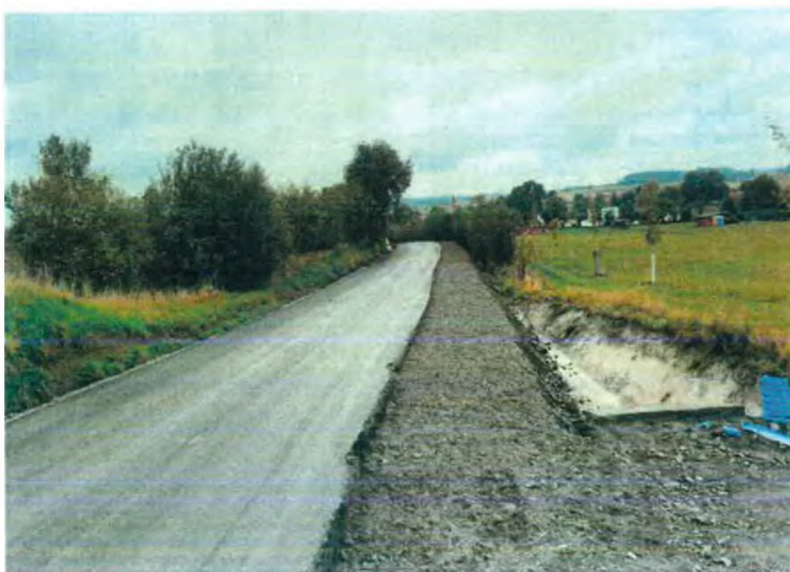
Zhotovení 1. konstrukční vrstvy ze ŠD tl. 150 mm
