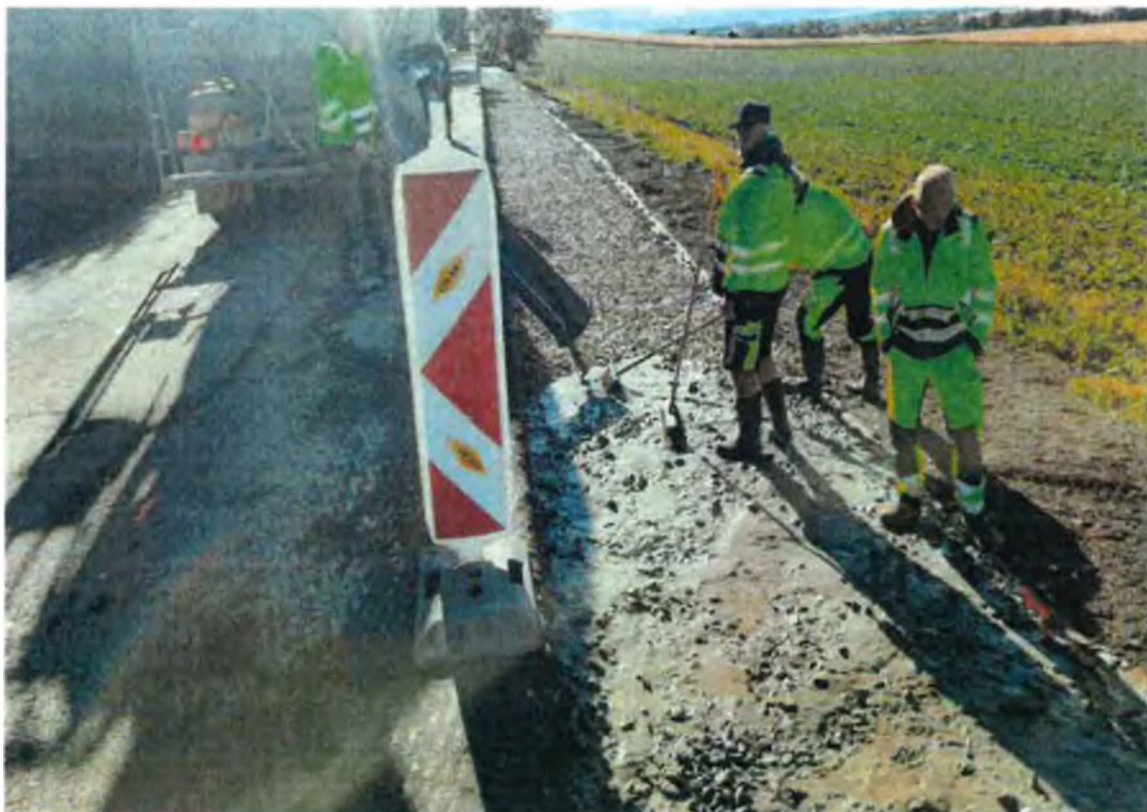
Zhotovení vrstvy ŠCM tl. 150 mm prolitím cementovou maltou
