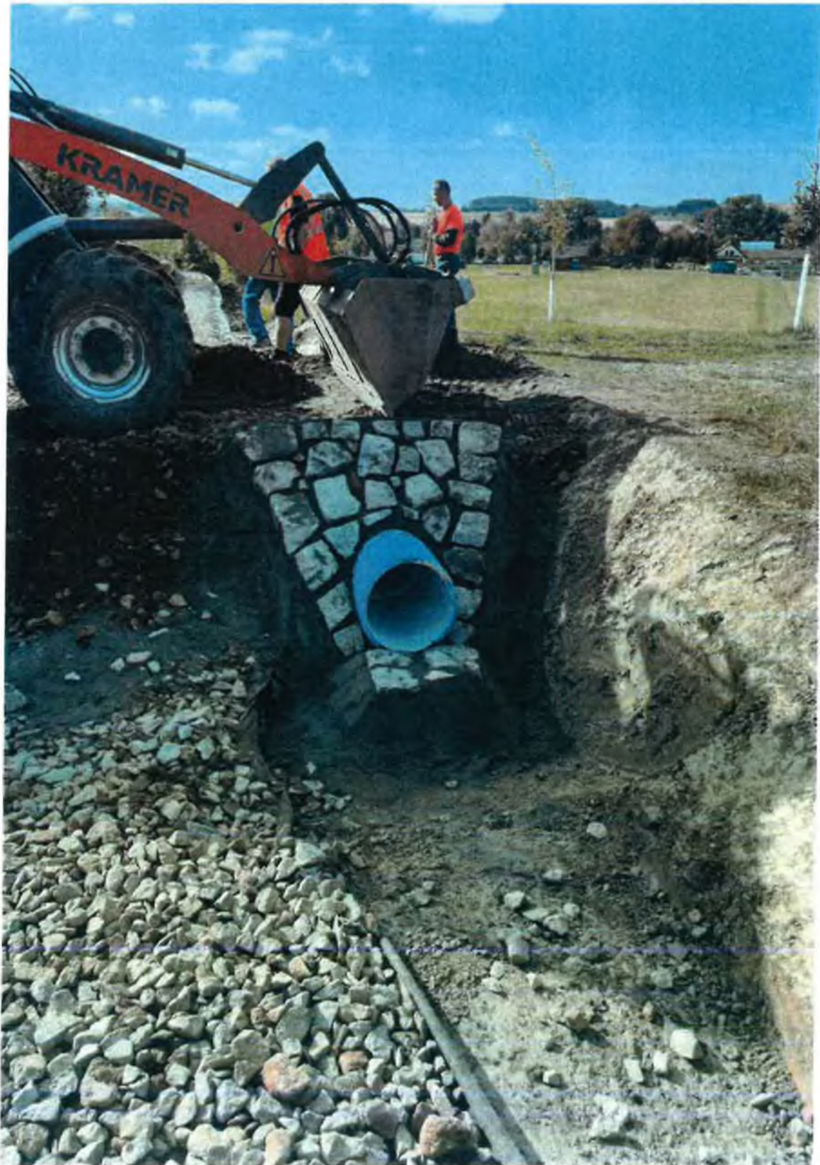
Podélný propustek DN 400 včetně šikmých čel
