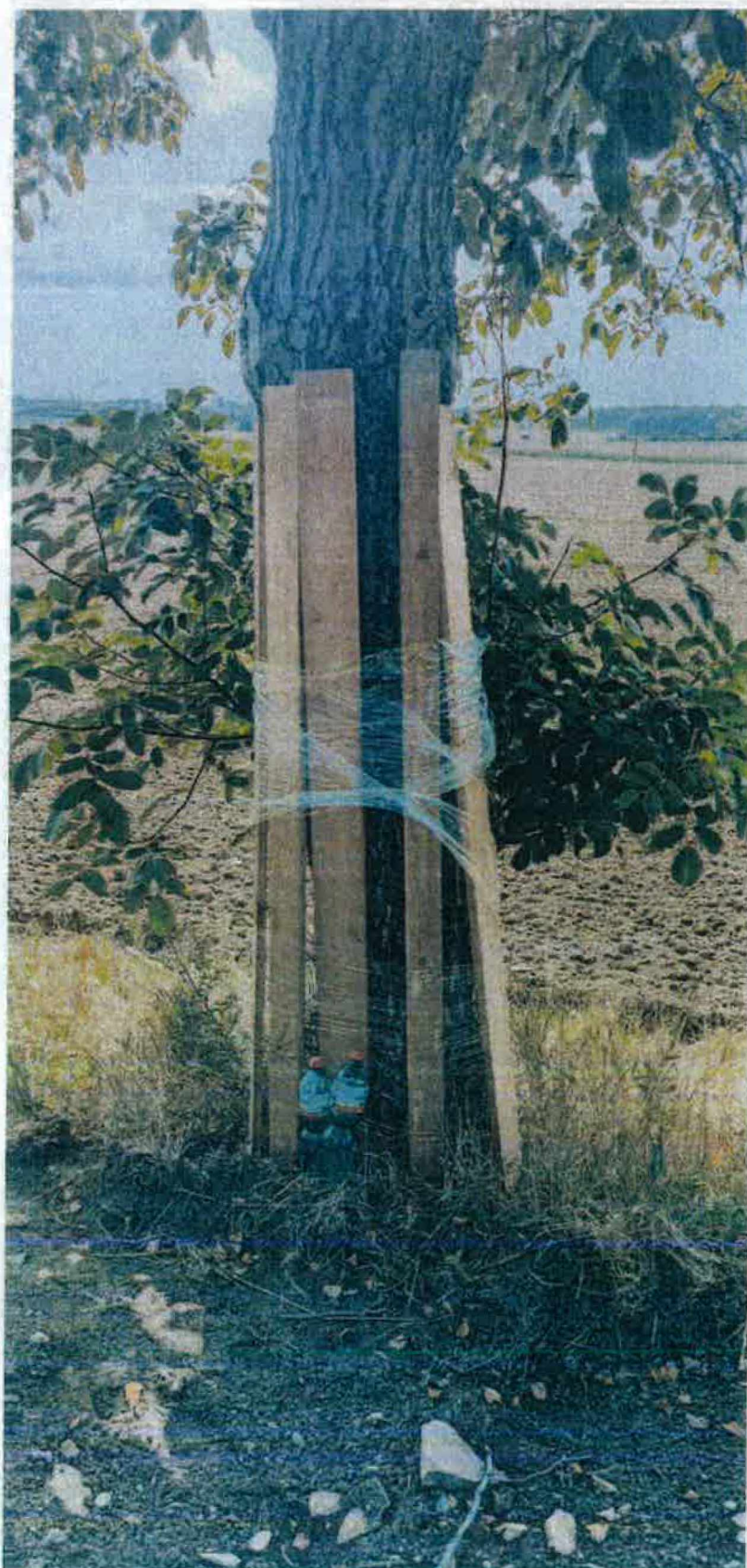
Ochrana stromů bedněním ze dřeva
