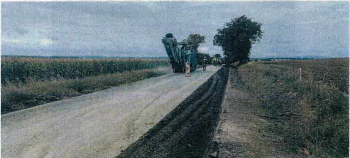
Rozfrézování komunikace v místech krajových sanací
