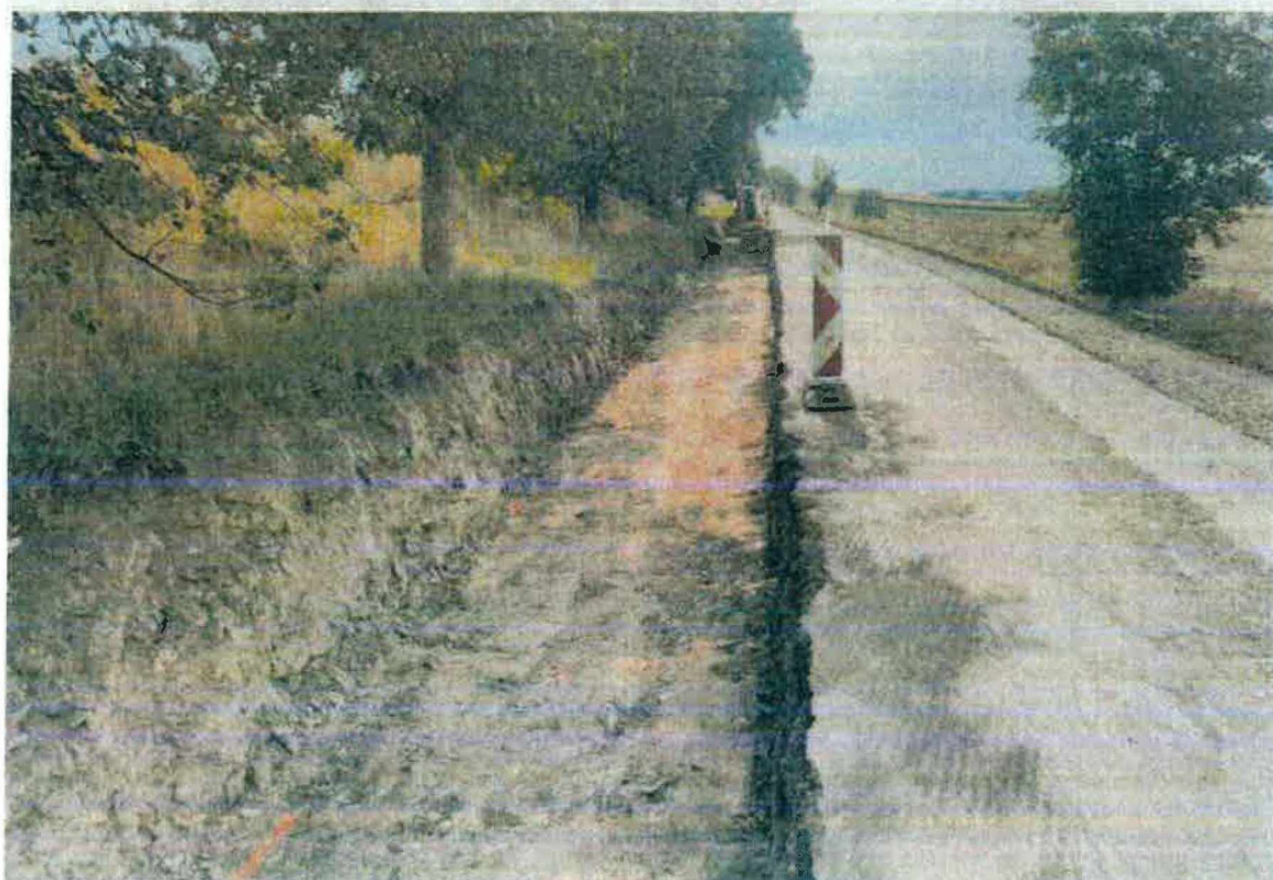
Odkop stávající kce a zeminy na úroveň paraplaně pravá strana
