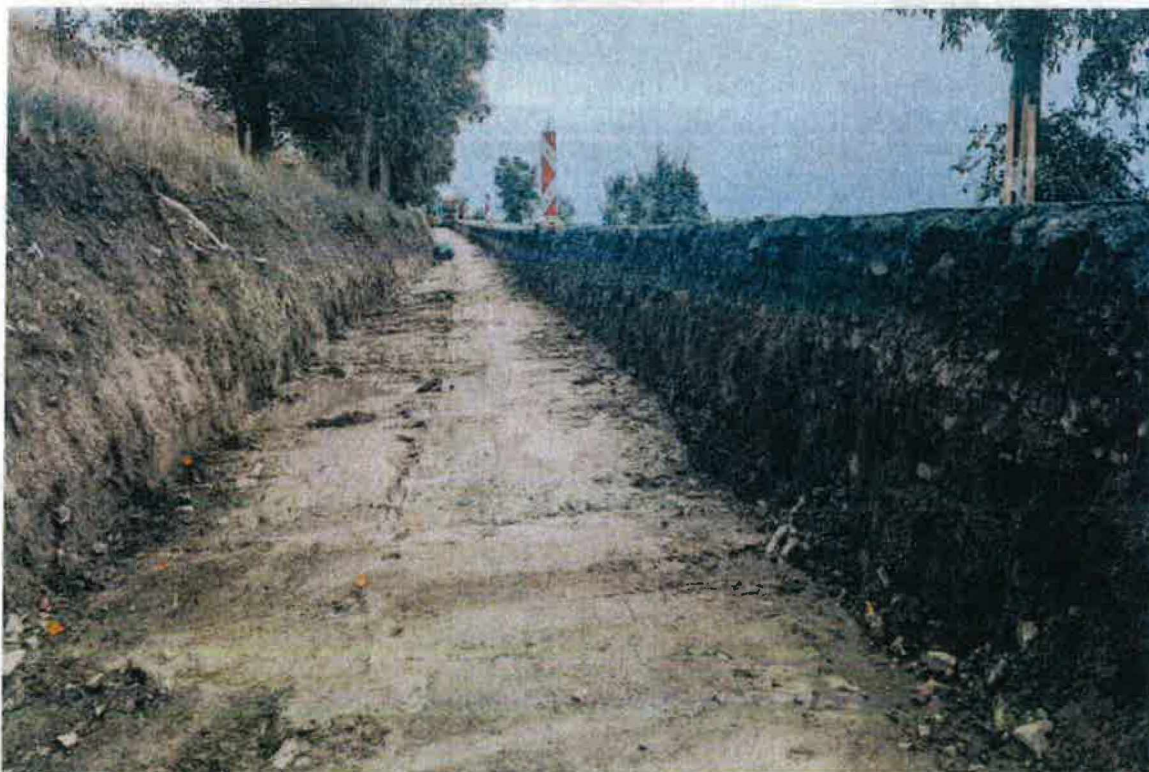
Odkop stávající kce a zeminy na úroveň paraplaně pravá strana
