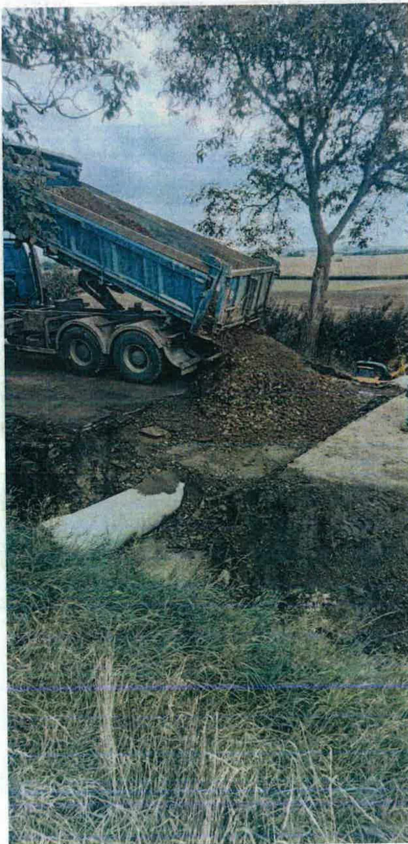
Zhotovení příčného propustku DN 500 ze ŽB roury
