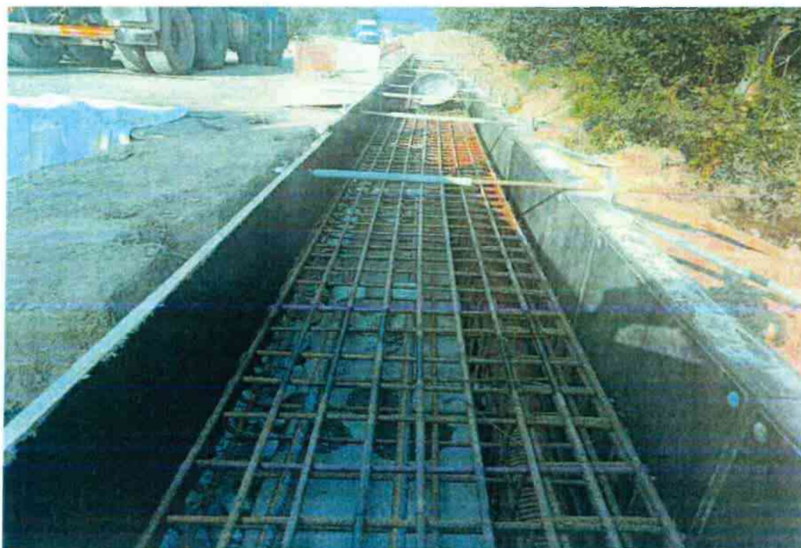
Bednění říms + vázání výztuže
