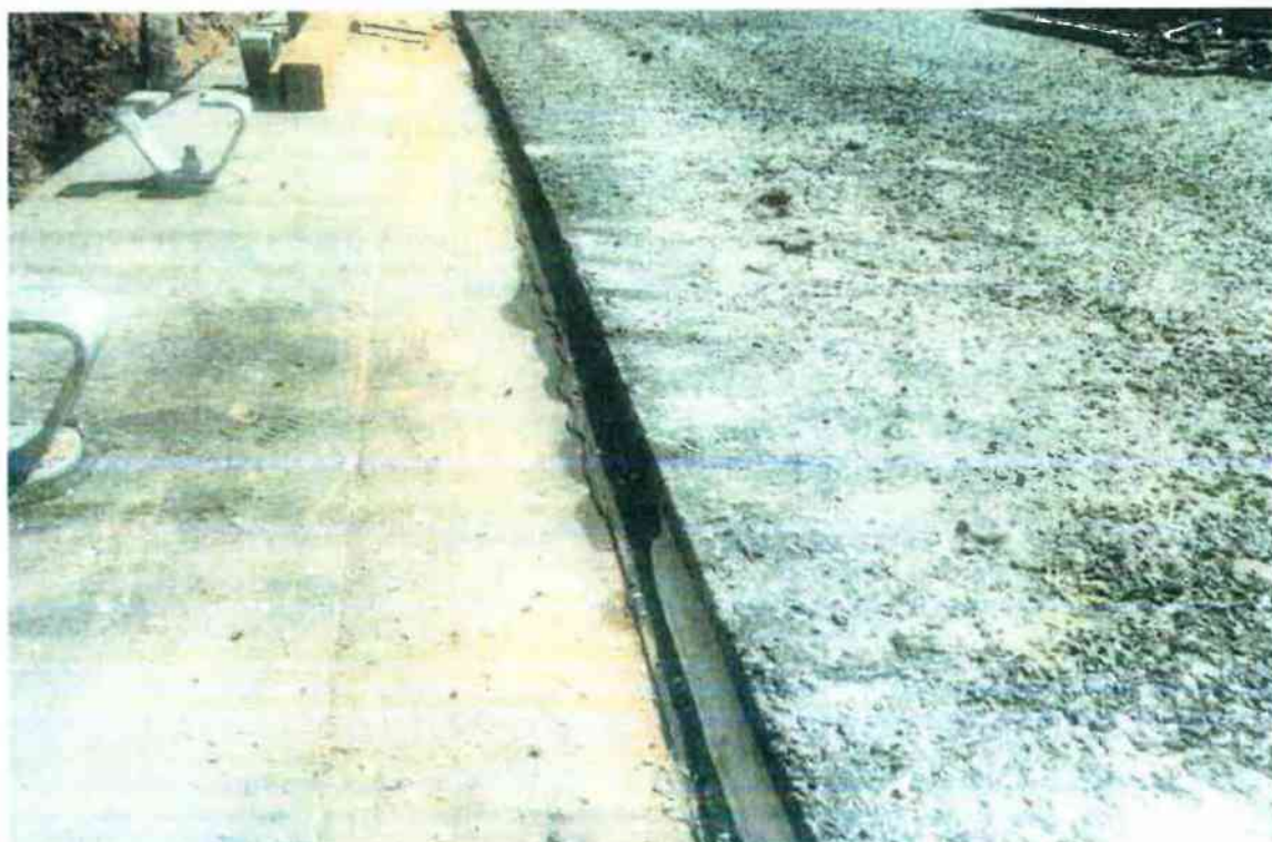
Litý asfalt tl. 35 mm + kotvy říms
