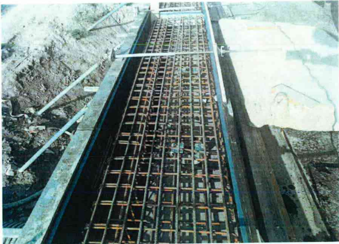
Bednění říms + vázání výztuže
