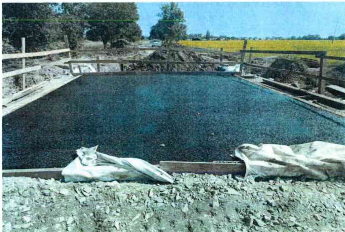
Zhotovení litého asfaltu tl. 35 mm
