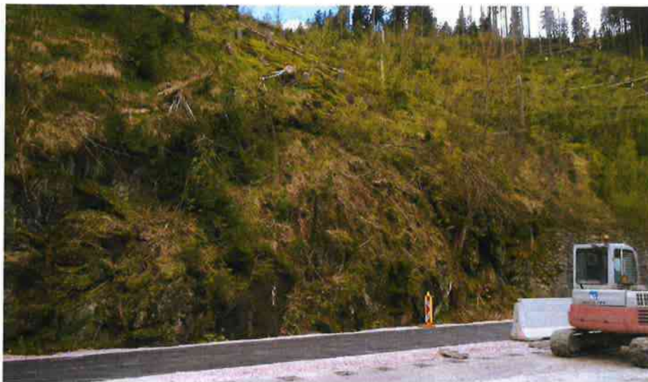
Pohled na řešený úsek svahu
