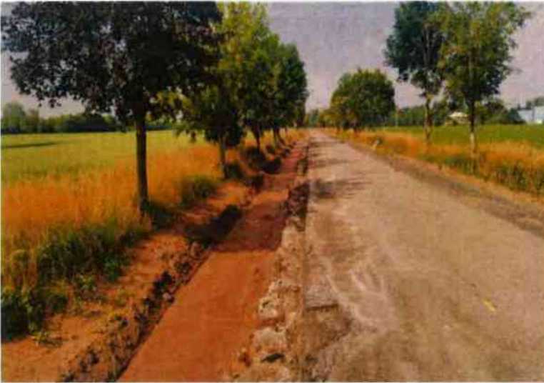
Odkop zeminy na úroveň parapláně
