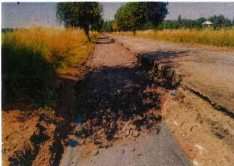
Sanace aktivní zóny včetně pokládky separační geotextilie
