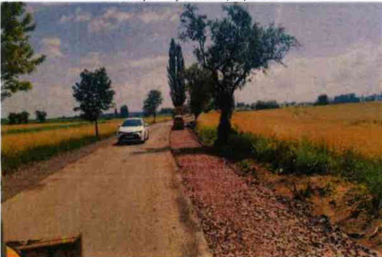
Zhotovení I: podkladní vrstvy včetně rovnání do profítu a hutnění
