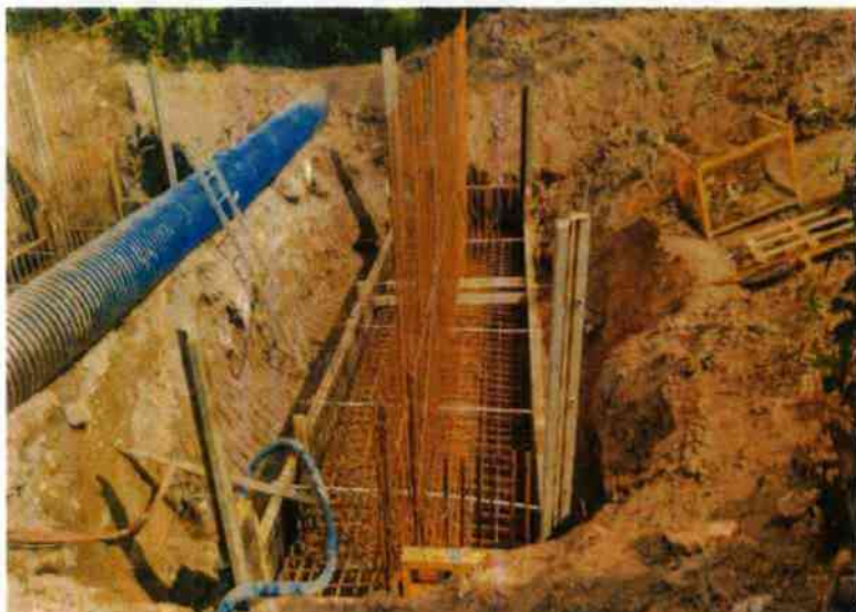
Bednění základu včetně podpěr včetně vázání výztuže
