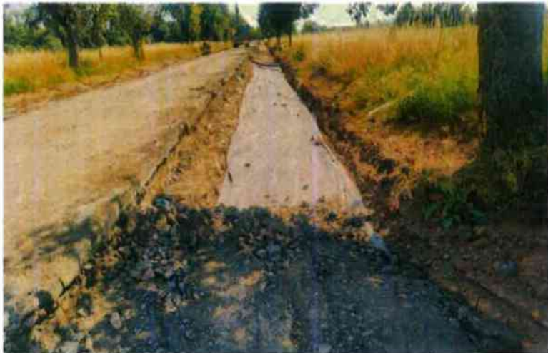
Σανίτς ενεργής ζώνης včetně osazení separační geotextilie
