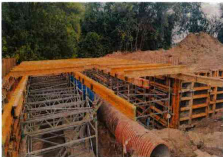
Bednění podpěr mostu včetně křídel a stropu + vázání výztuže
