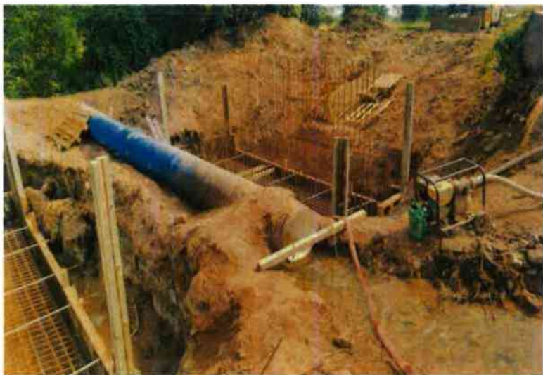
Bednění základu včetně podpěr včetně vázání výztuže
