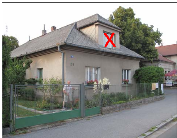
čelní fasáda a boční fasáda 1
