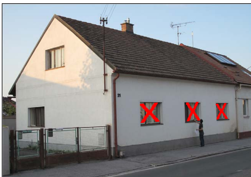
čelní fasáda a boční fasáda 1
