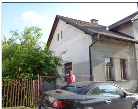
čelní a boční fasáda 2
