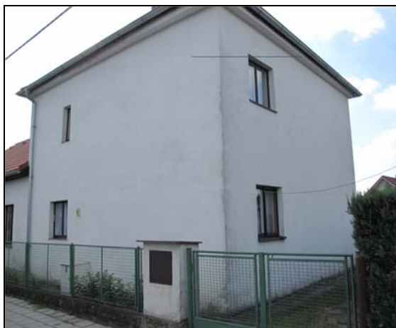
čelní a boční fasáda 1
