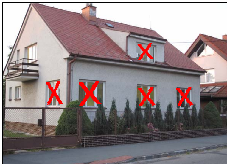
čelní fasáda a boční fasáda 1
