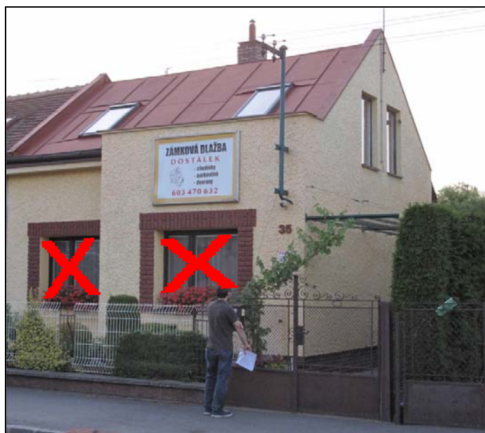
čelní a boční fasáda 2
