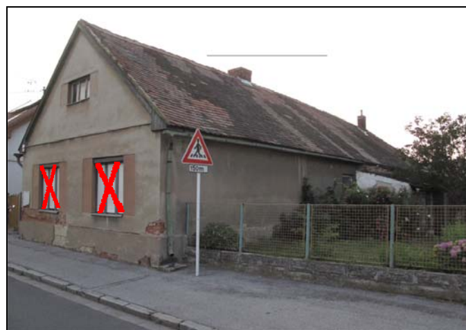
čelní a boční fasáda 2
