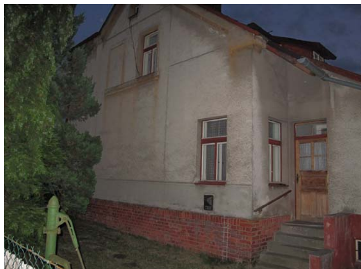
čelní a boční fasáda 2
