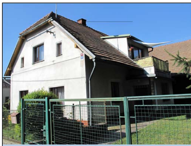
čelní a boční fasáda 2
