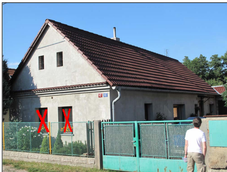
čelní fasáda a boční fasáda 2
