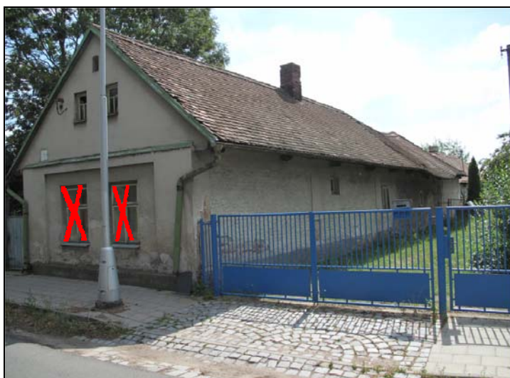
čelní fasáda a boční fasáda 1
