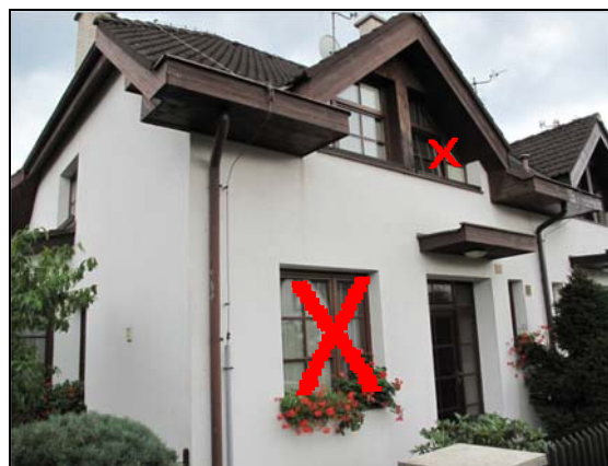
čelní a boční fasáda 2
