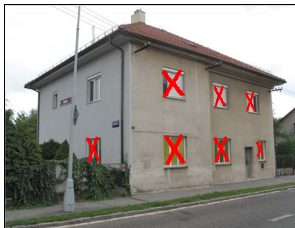
čelní fasáda a boční fasáda 2
