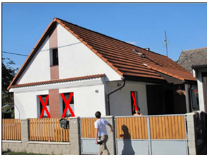
čelní fasáda a boční fasáda 2
