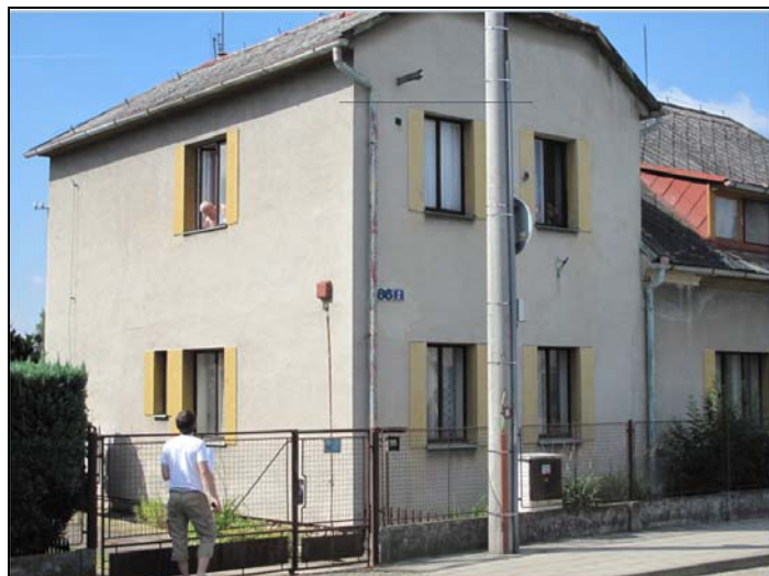
čelní a boční fasáda 2
