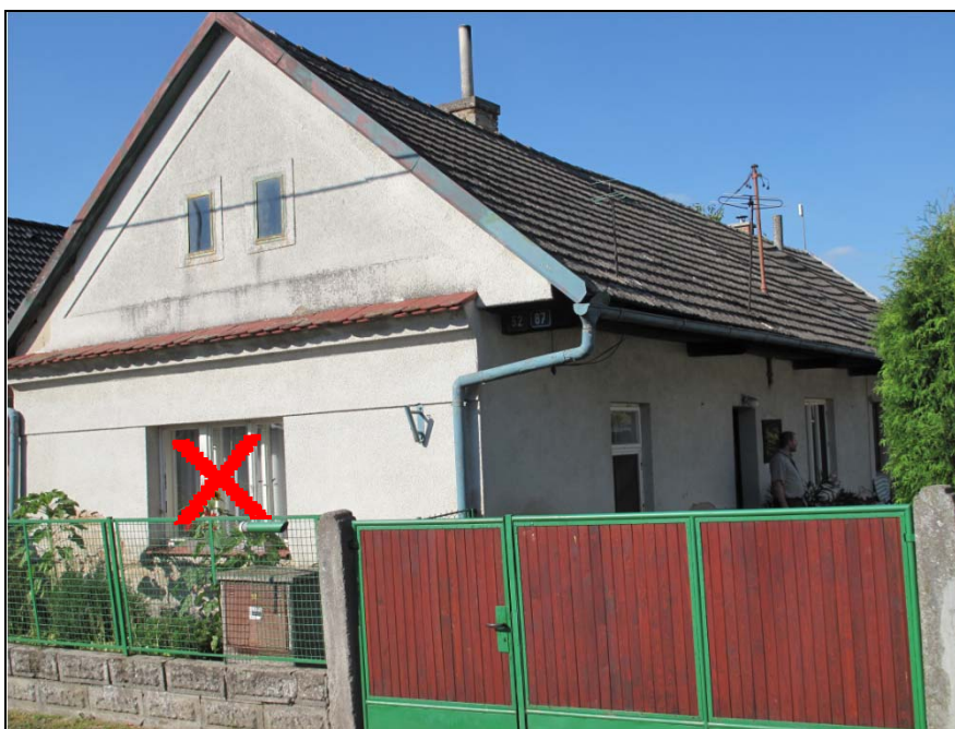
čelní fasáda a boční fasáda 2
