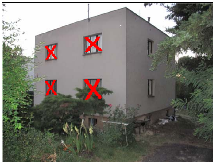
čelní fasáda a boční fasáda 2
