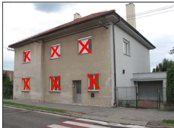
čelní fasáda a boční fasáda 1
