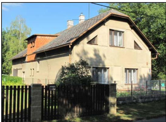
čelní a boční fasáda 1
