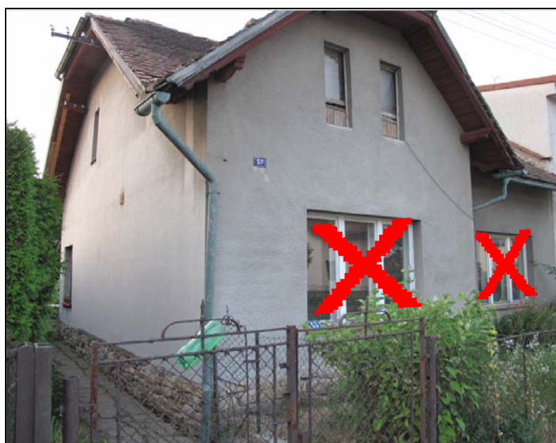
čelní fasáda a boční fasáda 1
