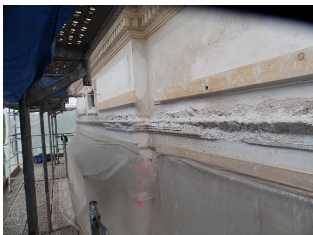
HLAVNÍ KORUNOVÁ ŘÍMSA SE ZDOBENÍM – OPRAVA
