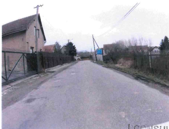
Hl. koroze, výtlučky, vysprávký, mozaikové trhliny
