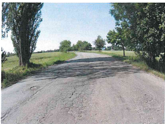
Ztráta kameniva z nátěru, vysprávky, vyjeté koleje
