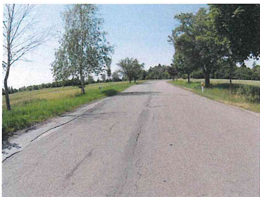
Vysprávkky, ztráta kameniva z nátěru, mozaikové trhliny
