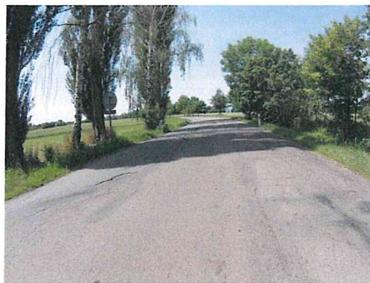
Mozaikové trhliny, vysprávka, ztráta kameniva z nátěru
