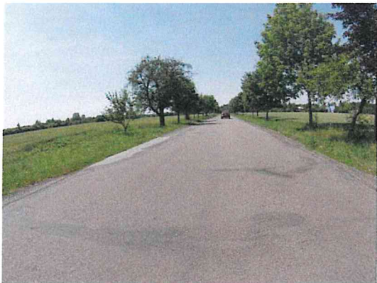
Vysprávky, mozaikové trhliny, olamování okrajů vozovky
