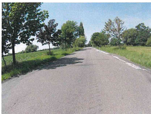
Vyjeté koleje, olamování okrajů vozovky
