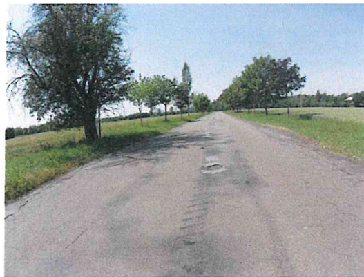
Olamování okrajů vozovky, výtluky, mozaikové trhliny
