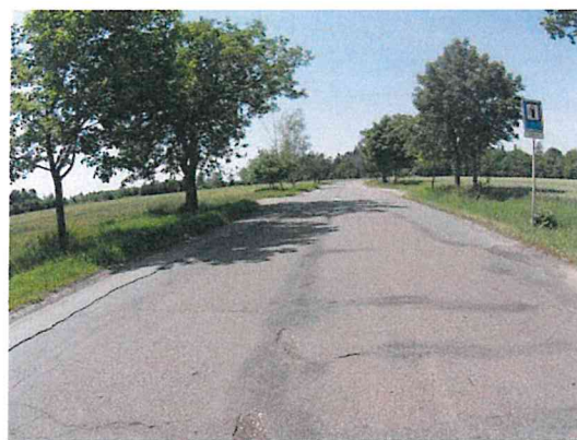
Vysprávkky, ztráta kameniva z nátěru, mozaikové trhliny
