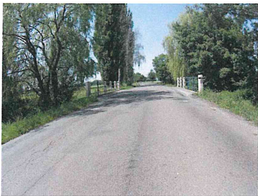
Mozaikové trhliny, vyjeté koleje
