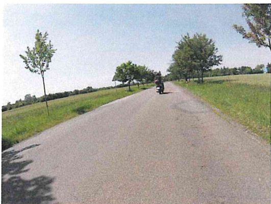
Vysprávky, mozaikové trhliny, vyjeté koleje
