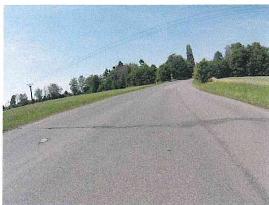
Příčná trhlina, vysprávka, vyjeté koleje
