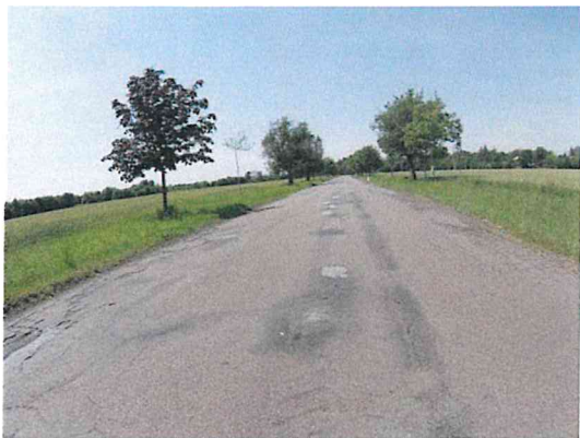
Olamování okrajů vozovky, vysprávkky, mozaikové trhliny
