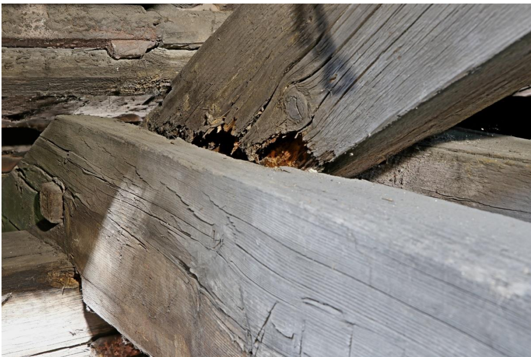
16. Detail poškození krokve a kleštiny v ohnisku napadení na předchozím snímku.
