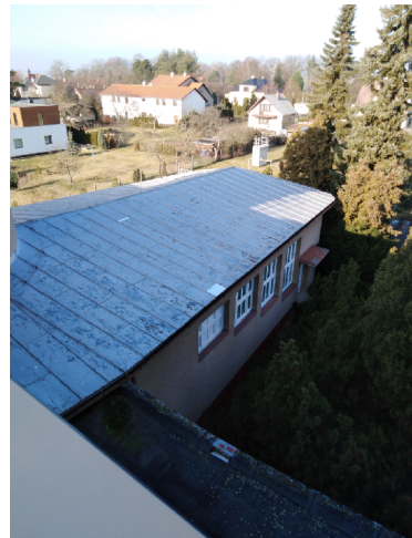
DEGRADOVANÝ NÁTĚR VLIVEM POVĚTRNOSTI
