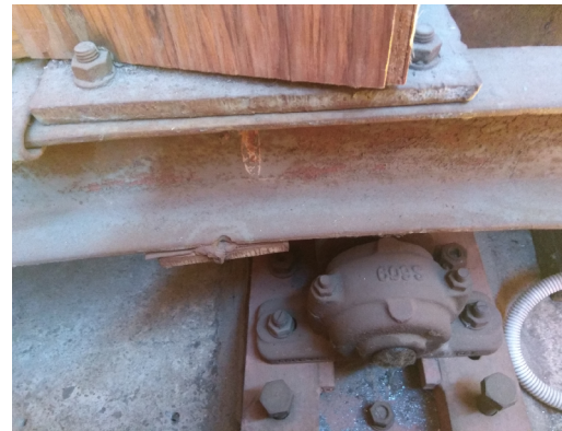
ZASTARALÝ MECHANISMUS POSUVNÉ STŘECHY KOPULE
