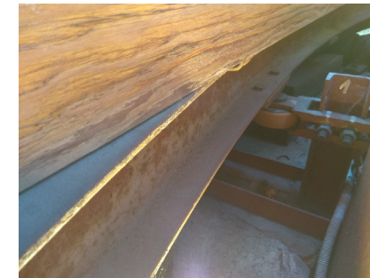
ZASTARALÝ MECHANISMUS POSUVNÉ STŘECHY KOPULE
