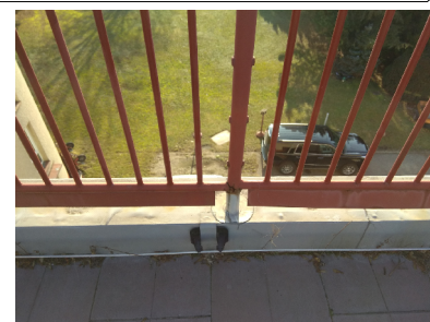
DEGRADACE OCELOVÉHO ZÁBRADLÍ NA STŘECHÁCH
