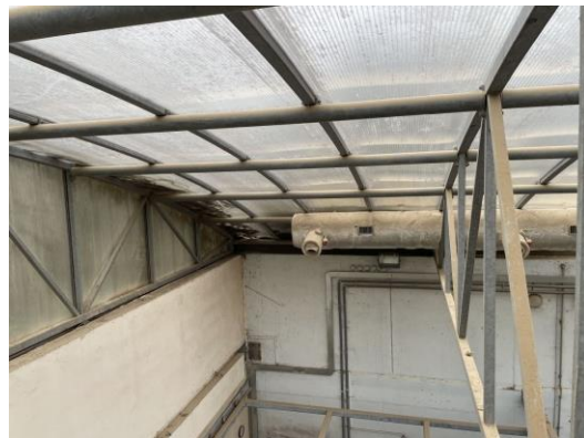
ČELO A OBLOUK Z INTERIÉRU 2
