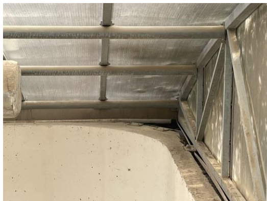
ČELO A OBLOUK Z INTERIÉRU 1
