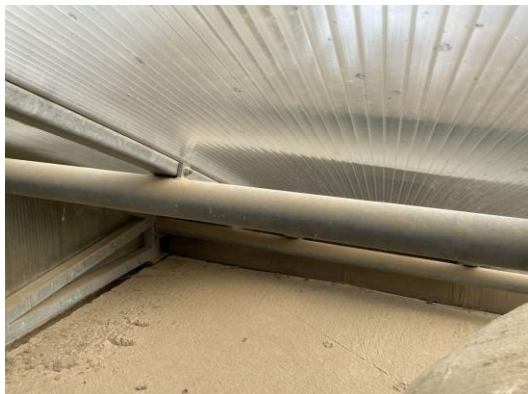
OBLOUK – PATA SVĚTLÍK z INTERIÉRU
