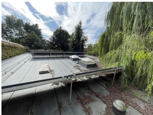
STŘECHA - MĚŘ - OCHRANA
