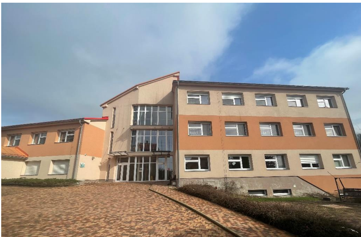
Obrázek 5 Jižní pohled na objekt E v areálu Domova na Stříbrném vrchu určený k instalaci FVE Zdroj: terénní šetření
