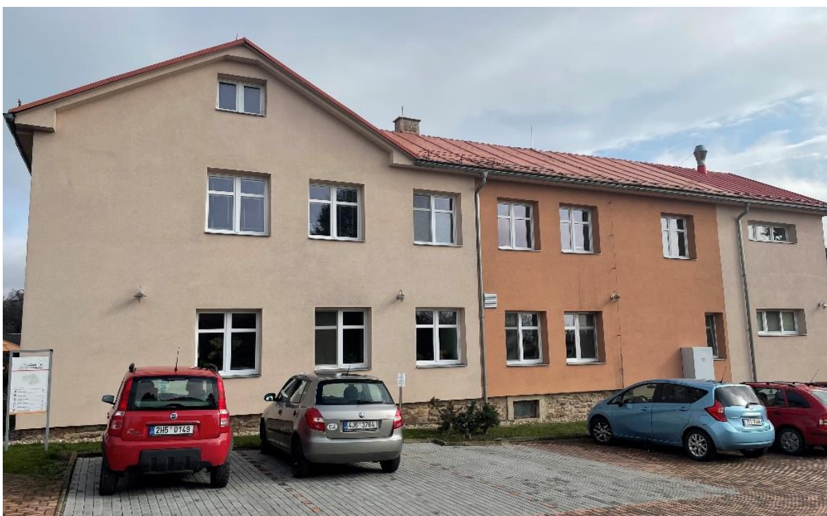
Obrázek 7 Jižní pohled na objekt D v areálu Domova na Stříbrném Vrchu určený k instalaci FVE Zdroj: terénní šetření
