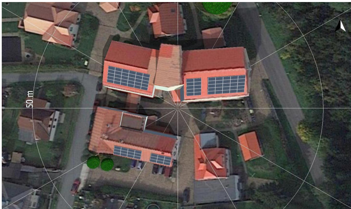
Obrázek 1 Fotovoltaická elektrárna na objektu Domov na Stříbrném Vrchu – situační pohled
